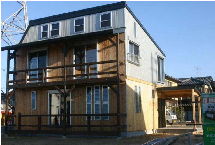
モデル住宅B (県産木材使用量 39.46m 3 ) <屋根>杉板 厚さ 30mm 金属板(GL鋼板)葺き <外壁>土壁 厚さ 45mm 金属板(GL鋼板)貼り、一部杉板縦貼り <内壁>杉板 厚さ 30mm、 一部杉板(厚さ30mm)上に石膏塗り厚さ 10mm+杉腰板貼り
