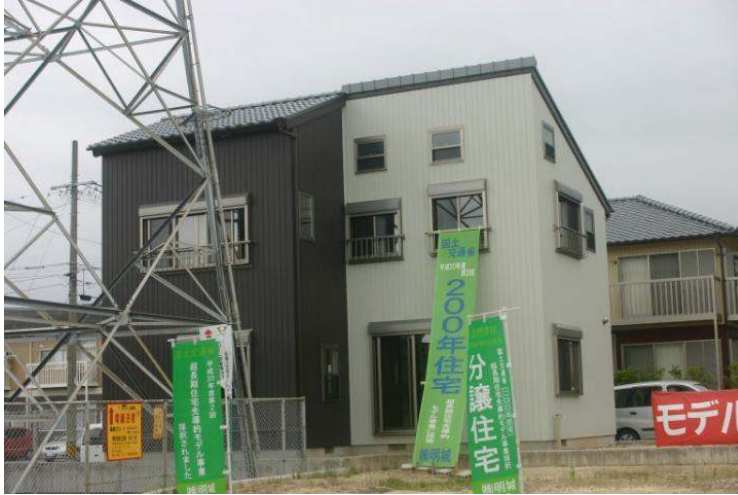
モデル住宅A (県産木材使用量 38.14m 3 ) <屋根>杉板 厚さ 30mm 日本瓦土葺き <外壁>土壁 厚さ 45mm 金属板(GL鋼板)貼り <内壁>杉板 厚さ 30mm表し
