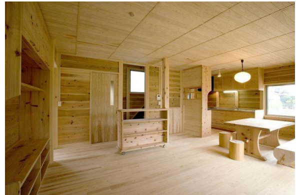
モデル住宅A (県産木材使用量 38.14m 3 ) <屋根>杉板 厚さ 30mm 日本瓦土葺き <外壁>土壁 厚さ 45mm 金属板(GL鋼板)貼り <内壁>杉板 厚さ 30mm表し
