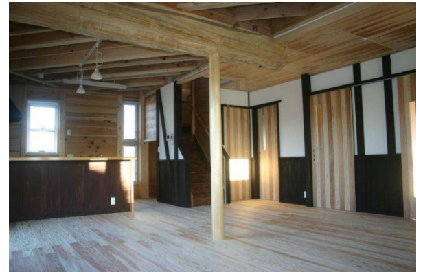
モデル住宅B (県産木材使用量 39.46m 3 ) <屋根>杉板 厚さ 30mm 金属板(GL鋼板)葺き <外壁>土壁 厚さ 45mm 金属板(GL鋼板)貼り、一部杉板縦貼り <内壁>杉板 厚さ 30mm、 一部杉板(厚さ30mm)上に石膏塗り厚さ 10mm+杉腰板貼り
