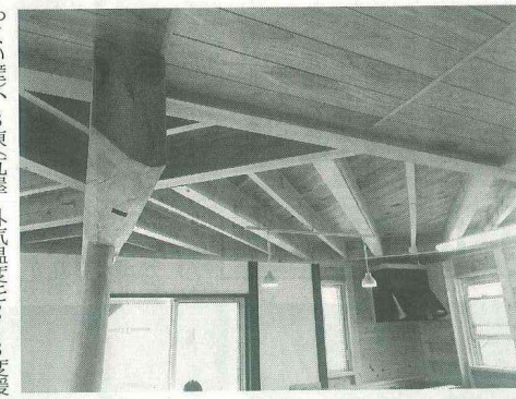
独自開発したムク材仕様の床耐震工法「アプリケーション」(板壁)の2010年9月測定結果など報告
